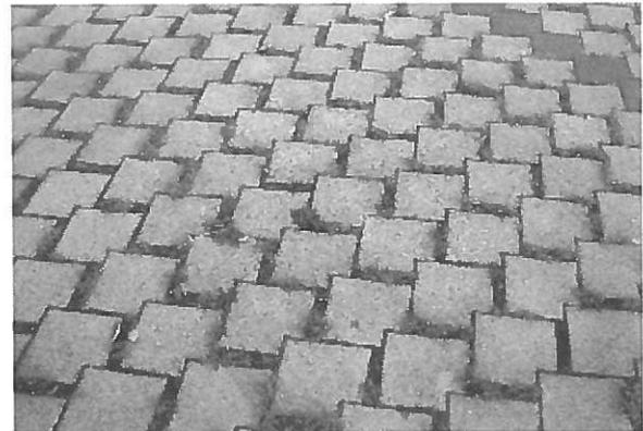
Foto 2: Beispiel 2 gasdurchlässiges Pflaster
