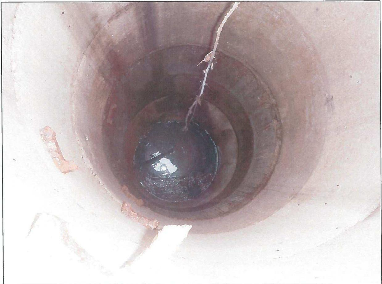
Foto 1: Revisionschacht der das Plangebiet querenden Entwässerungsleitungen
