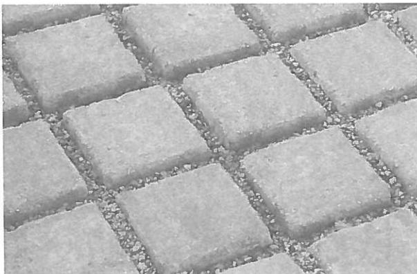
Foto 1: Beispiel 1 gasdurchlässiges Pflaster
